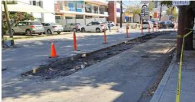
Inicio excavaciones para drenaje pluvial
