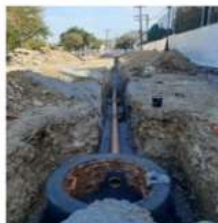
Trabajos infraestructura sanitaria
