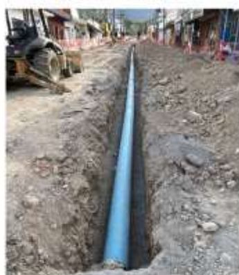
Tendido de tubería
