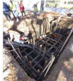
Trabajo en Parque Colado de cisterna
