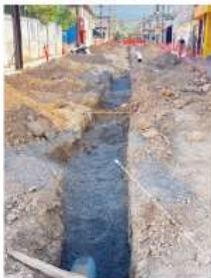
Tendido de arena en red hidráulica
