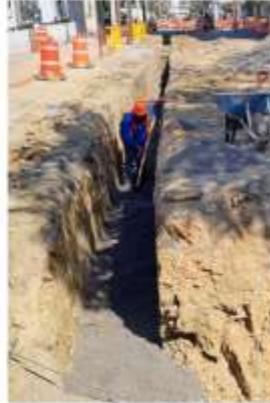
Colocación de base para tubería sanitaria
