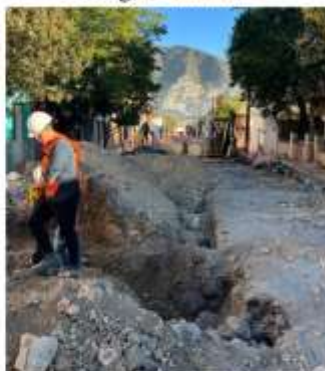
Excavación de ramales de descargas sanitarias
