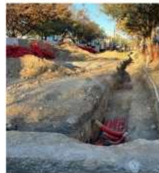
Trabajo de instalaciones eléctricas
