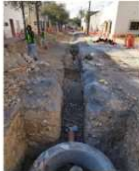
Trabajo en Calle Drenaje sanitario
