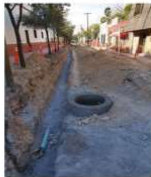
Trabajos líneas de agua potable
