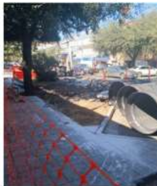
Demolición de carpeta y cordones
