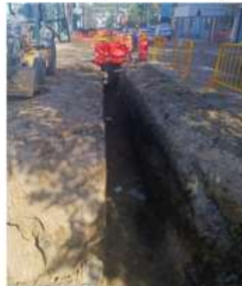
Afina zanja línea de drenaje
