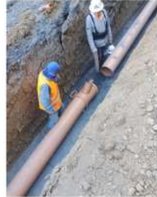
Instalación drenaje sanitario
