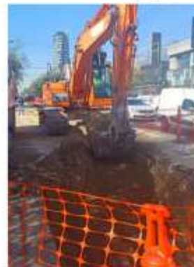
Excavaciones drenaje pluvial
