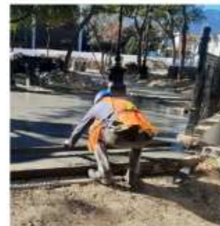
Colado firme perímetro Kiosco
