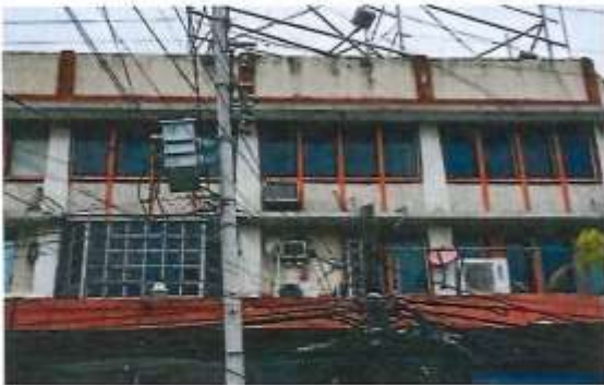
Figura 31 Edificación en Río Tamazunchale.
