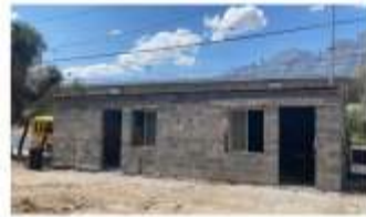
Rehabilitación área de necropsia
